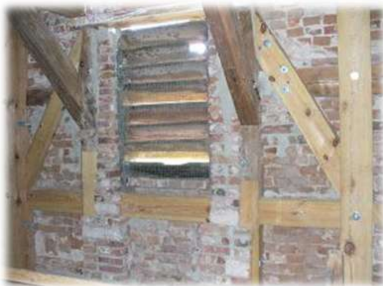
Die "Beule" an der Turmsüdseite ist ausgebessert
